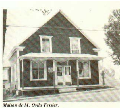
Maison de M. Ovila Tessier.
