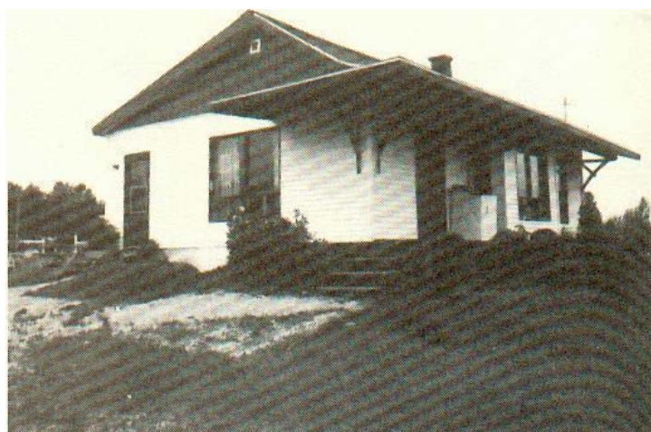
La gare transformée en résidence.
