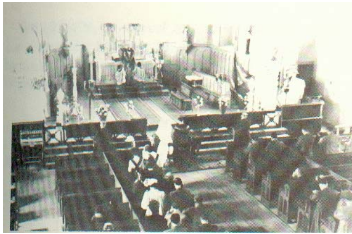
Vue de l'intérieur de l'église avant les premières transformations.
