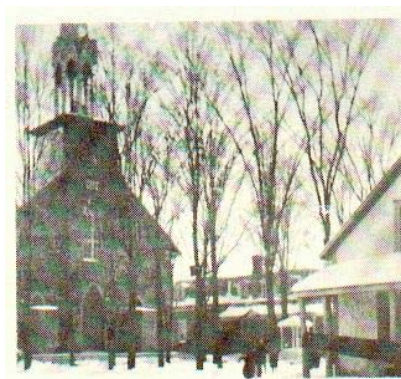
Vue du kiosque en avant de l'église à côté du presbytère.
